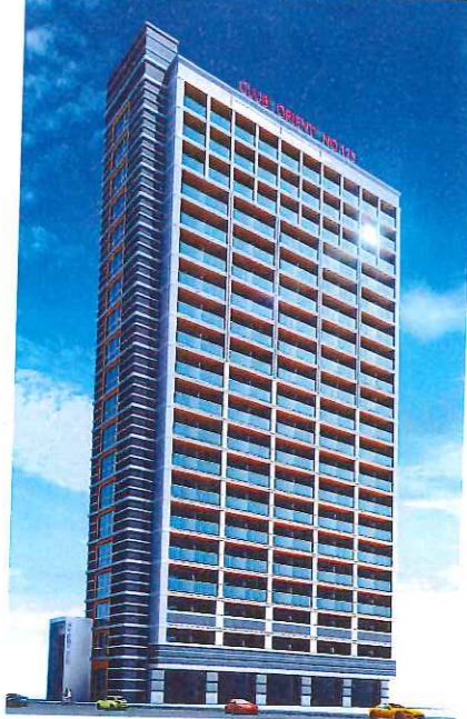
クラブオリエンツビル No.125 広島 (RC20階建、全190戸、広島市) 2019年10月完成
